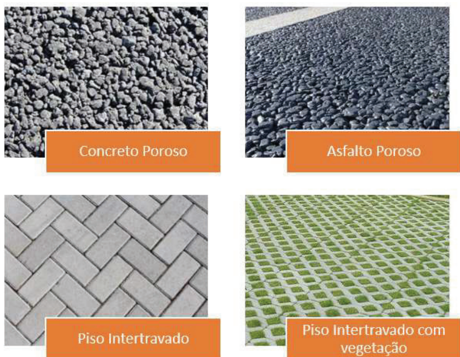
Figura 44 – Tipos de pavimentos permeáveis Fonte: Aguiar (2022)
