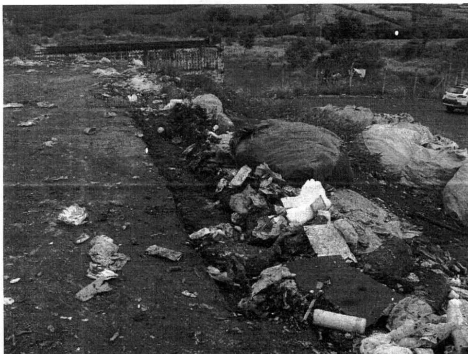
Figura 7 - Resíduos fora da área destinada ao recebimento
