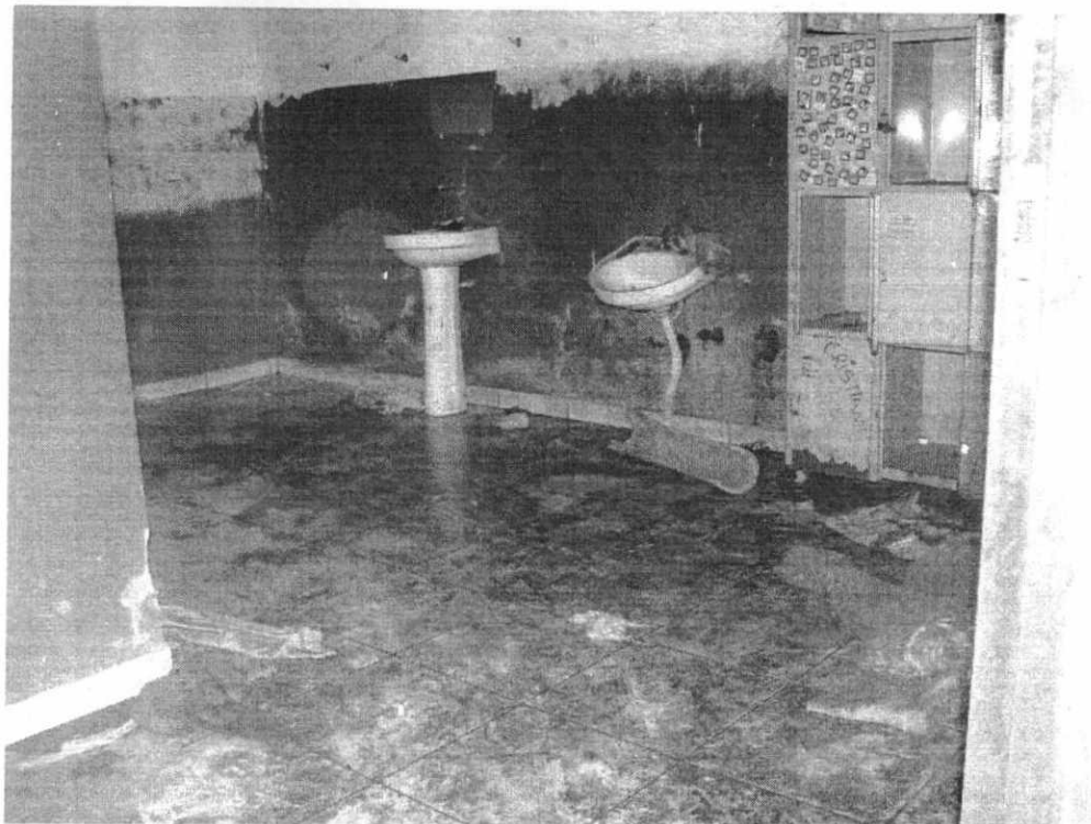
Figura 20 - Estrutura dos vestiários
