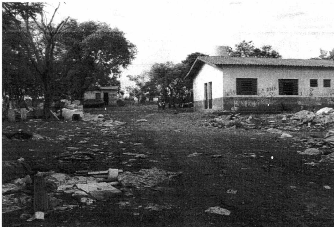
Figura 16 - Vista lateral da entrada da Central e da casa que atualmente é ocupada por uma família
