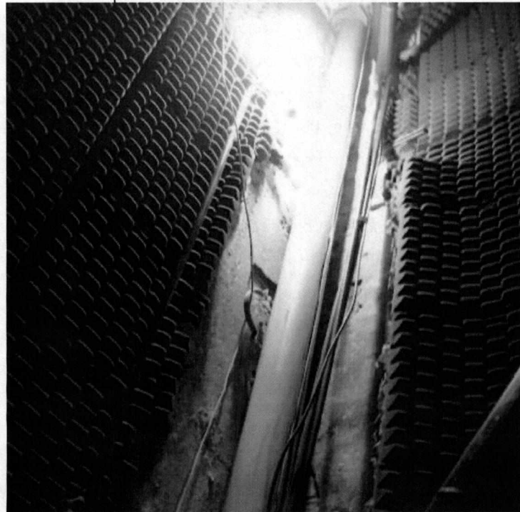
Local no interior do poço dos elevadores por onde descirão as águas por novos dutos.
