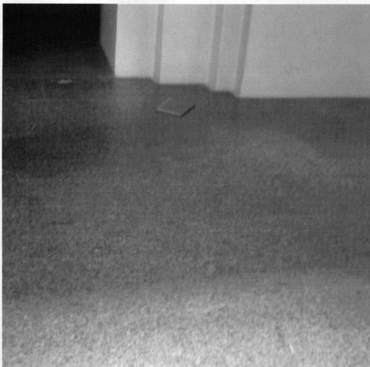
Parede e piso de granito Mauá que serão cortados para passagem dos dutos para conexão com as caixas coletoras que levarão para a rede.
