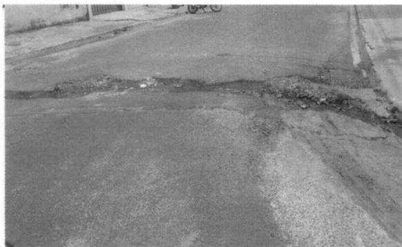
**JUSTIFICATIVA:** O buraco existente no local esta danificando os veículos e dificultando o tráfego pela via e aumentando o risco de acidentes devido ao estado deteriorado da mesma, causando transtornos para os moradores que transitam pelo local diariamente.
