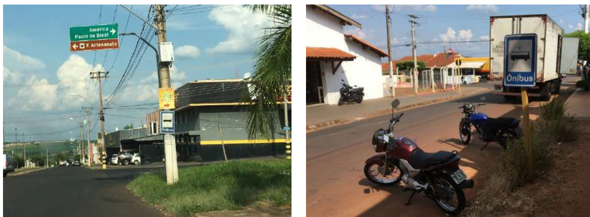
Figura 41 - Exemplos de diferentes tipologias de pontos de ônibus encontrados Ibitinga Fonte: Arquivo próprio
