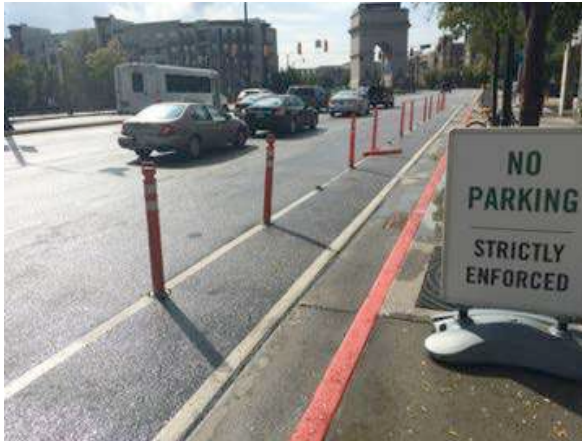
Figura 20 - Ciclovía temporária delimitada por balizadores Fonte: NACTO (2018, p. 33)
