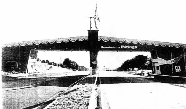
Figura 1 - PIT Portal de Entrada
