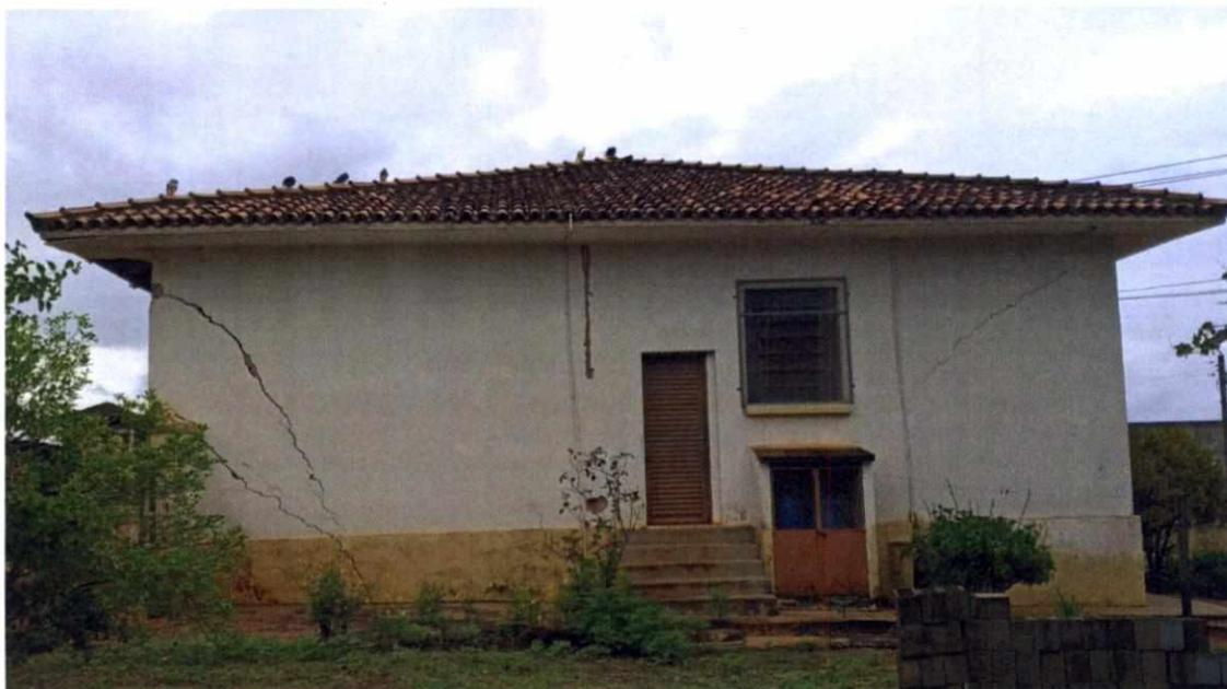
*PAREDE DO PROBLEMA OCORRIDO POR CAUSA DE INFILTRAÇÃO DE ÁGUA NO CANTO ESQUERDO, PAREDE DO FUNDO DA COZINHA; ALINHAMENTO DO BEIRAL NORMAL; ESPIGÃO NORMAL CAPELO SEM PROBLEMA ALGUM, NEM PARA AS POMBAS. COM O RECALQUE OCORRIDO NA ORDEM DE 1,0 CM PROVOCOU UM MOMENTO ANTI HORARIO EM TODA PAREDE, MAIS O INERCIA DA ESCADA E DA CASA DE GÁS ( OBS. "10 VEZES MELHOR E CORRETA, COMPARANDO COM A ESCOLA NOVA; E ELOGIADA POR TODOS VEREADORES DA SITUAÇÃO.*
