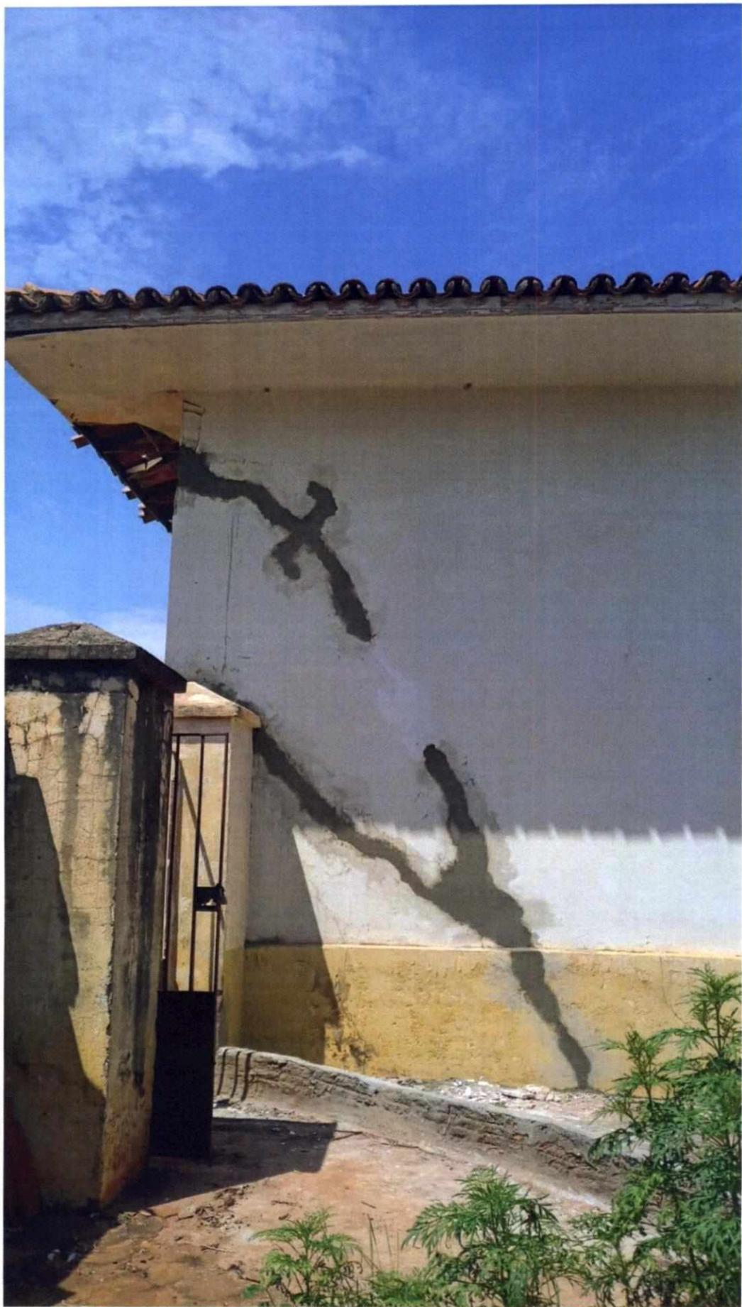
APÓS TOTAL VERIFICAÇÃO FOI FEITO , ENTÃO O ENCHIMENTO DAS RACHADURAS TANTO INTERNAMENTE COMO EXTERNAMENTE; COM PRODUTO ADEQUADO PARA PRODUZIR A ADERENCIA NO LOCAL ONDE A TENSÃO TINHA SIDO DESLOCADA, E RETORNANDO O CAMINHAMENTO ORIGINAL DAS CARGAS E DANDO ALIVIO AO OTIMO TELHADO NESTE CANTO.
