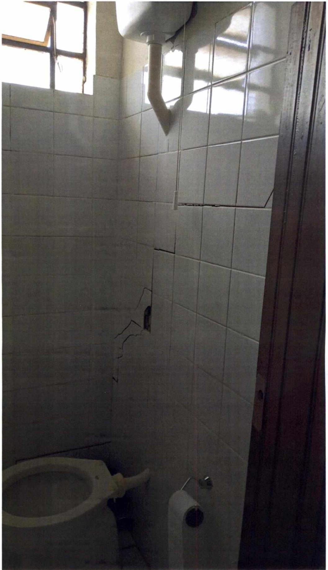
**BANHEIRO COM PEQUENO VAZAMENTO, NADA QUE O ENCANADOR DA PREFEITURA FOR AO CAMBARATIBA ½ DIA SE ELE FOR LENTO RESOLVE. NO BEBEDOR MESMA COISA, SIMPLES. ESTA FISSURA INTERNA NÃO VAI CAIR A ESCOLA, BASTA FAZER O DESCRITO ANTERIORMENTE, COM A FITA E O NOVO REBOCO NESTA ÁREA.**
