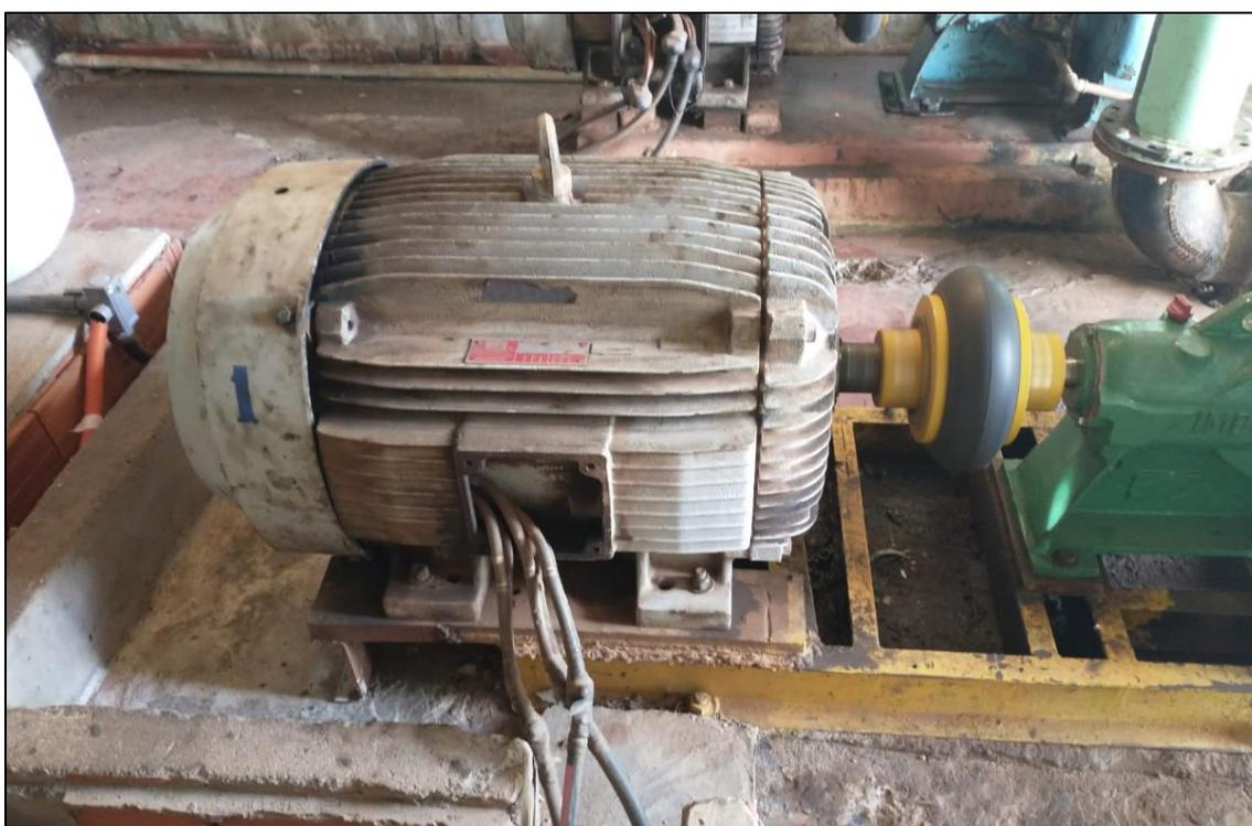
Figura 12 – Sistemas Motrizes - Sistema 1 – Motor 100CV – Bomba ETA
